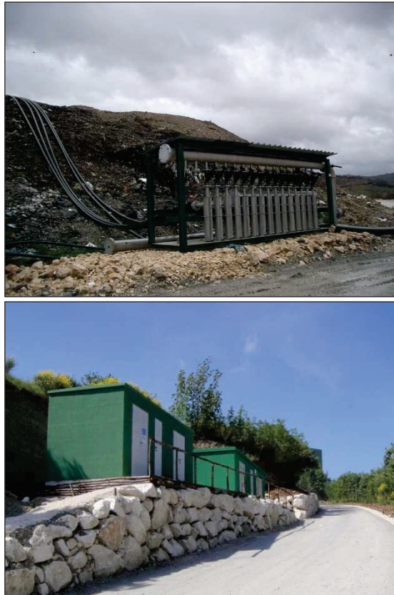
Fig. 9 – Impianto di captazione del biogas di discarica e derivazione linea elettrica.
