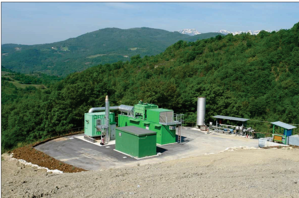
Fig. 10 – Impianto di cogenerazione del biogas di discarica.
